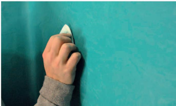
Die Oberfläche wird mit geschliffenen Steinen poliert. So entstehen ausdrucksstarke, glänzende Oberflächen von warmer, samtiger Haptik.
